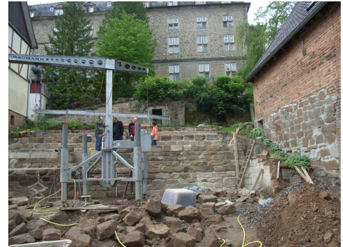
Baustelle Lange Straße 21
